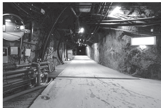
図 4 コントロールルーム前から坑口を見る
